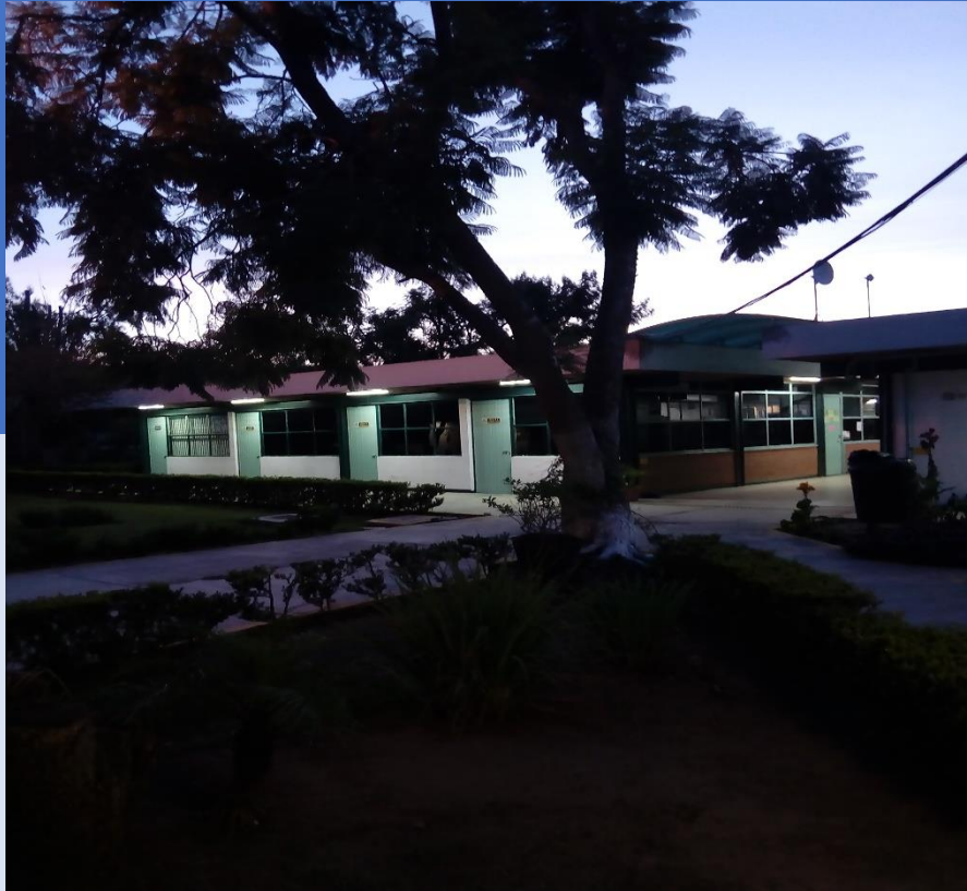
Reemplazo de lámparas fluorescentes por lámparas led en pasillos de Dirección y Posgrado
