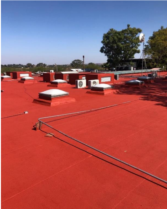
Ilustración 34 Impermeabilización de edificio de posgrado
