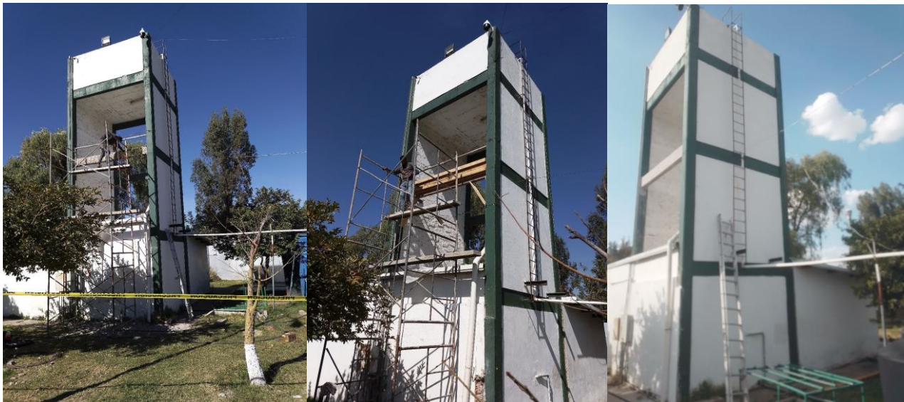
Ilustración 39 Reforzamiento de viga estructural del tinaco elevado
