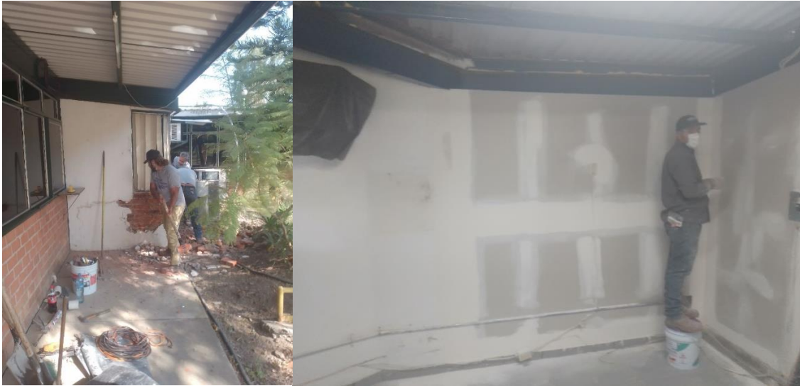
Ilustración 40 Reparación de muro en oficina del Depto. de Desarrollo Académico
