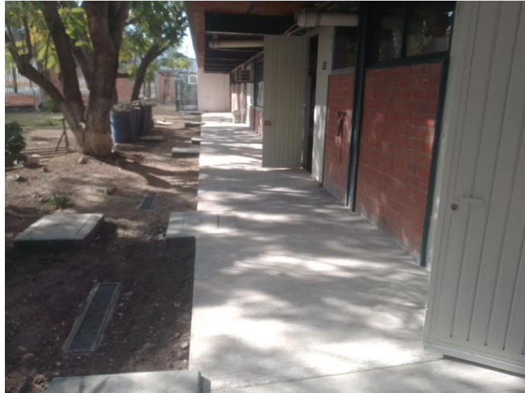
Ilustración 38 Banqueta de costado del edificio de posgrado después
