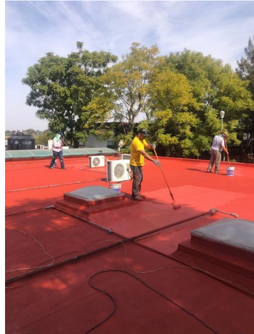
Ilustración 35 Impermeabilización de edificio de posgrado-2
