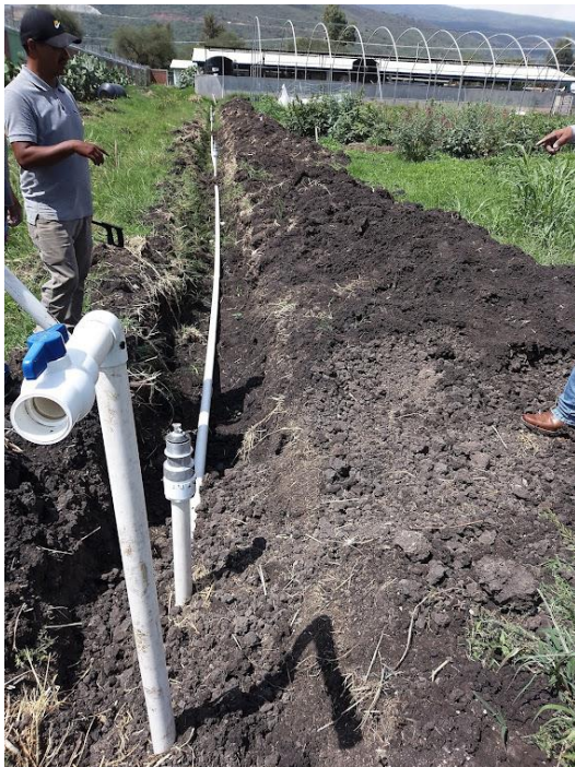
Ilustración 26 Tubería para sistema de riego de zona agrícola
