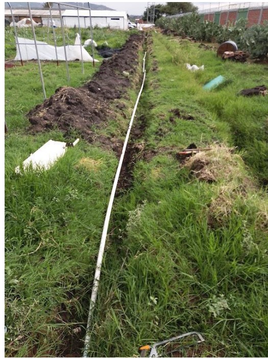
Ilustración 27 Tubería para sistema de riego de zona agrícola-2
