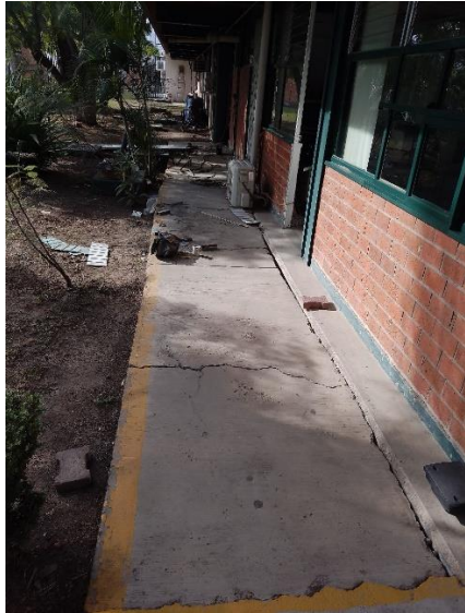
Ilustración 37 Banqueta de costado del edificio de posgrado antes
