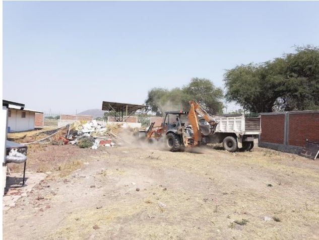
Ilustración 28 Limpieza de escombros antes
