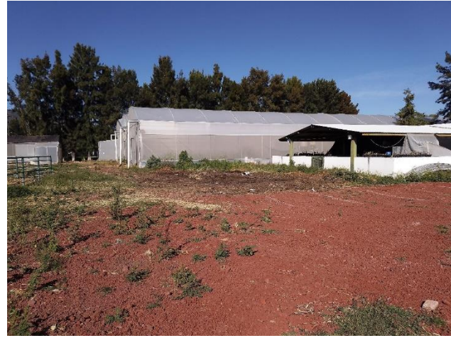
Ilustración 29 Limpieza de escombros después
